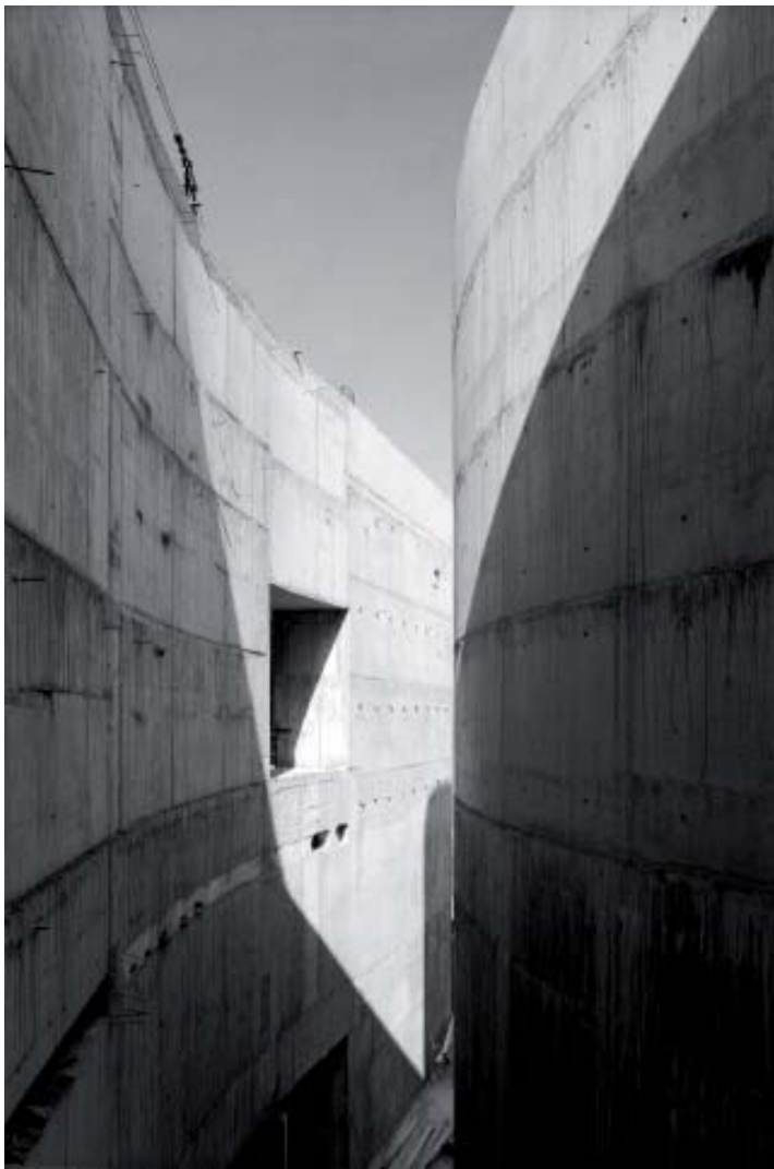
Vista del passatge de l'edifici en construcció Foto: Lluís Casals
